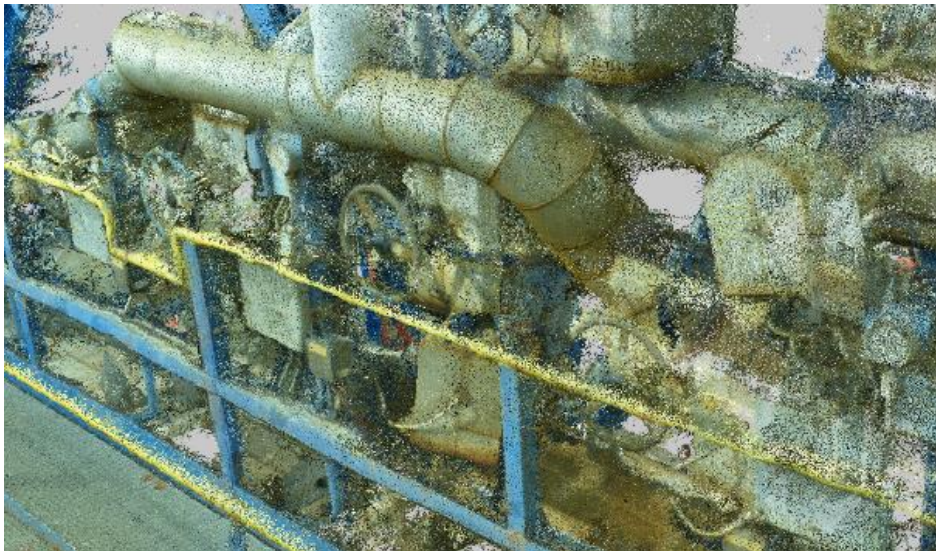
Figure 1 Exemple d'un nuage de points de site industriel
